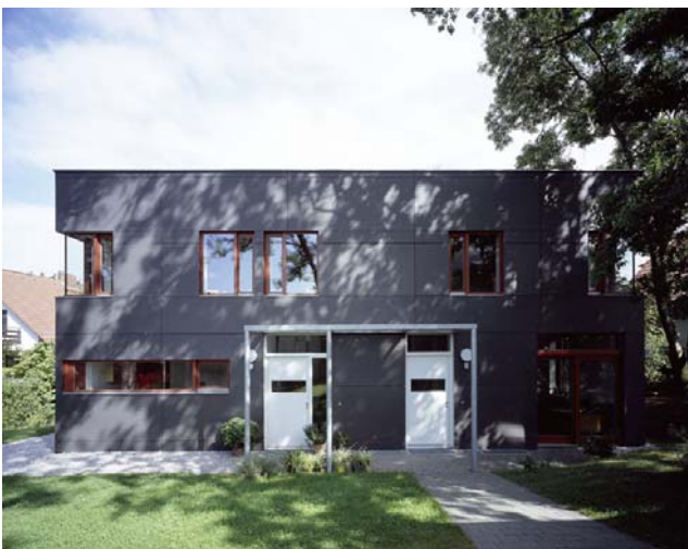
Zweifamilienhaus mit Holzheizung Quelle: solares bauen
