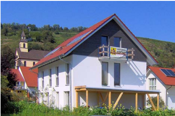
Wohngebäude mit Grundwasser-Wärmepumpe Quelle: solares bauen
