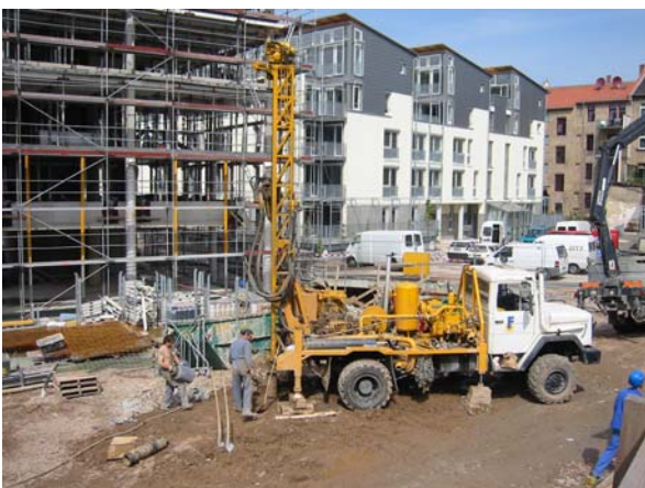
Bohrung für die Erdwärmesonden einer Wärmepumpe
