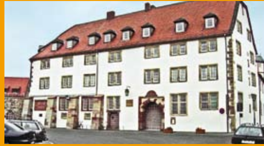
Gebäudetyp: Justizvollzugsanstalt (Sanierung) Größe: 27.468 m 2
