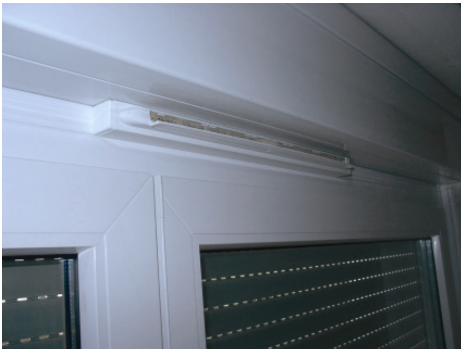
Abb. 2: Außenluftdurchlass mit Sturmsicherung (Quelle: Aerex HaustechnikSysteme).
