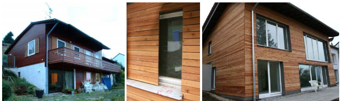
Das Niedrigenergiehaus in Konstanz vor und nach der Sanierung
